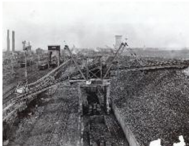
17: Het bietenplein met gecombineerde tram- en treinsporen.
