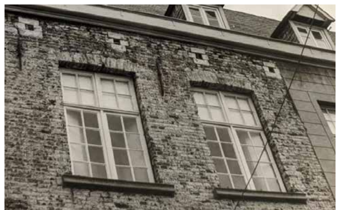
Gevels na afkappen bepleistering (1983) met het originele houten schrijnwerk
