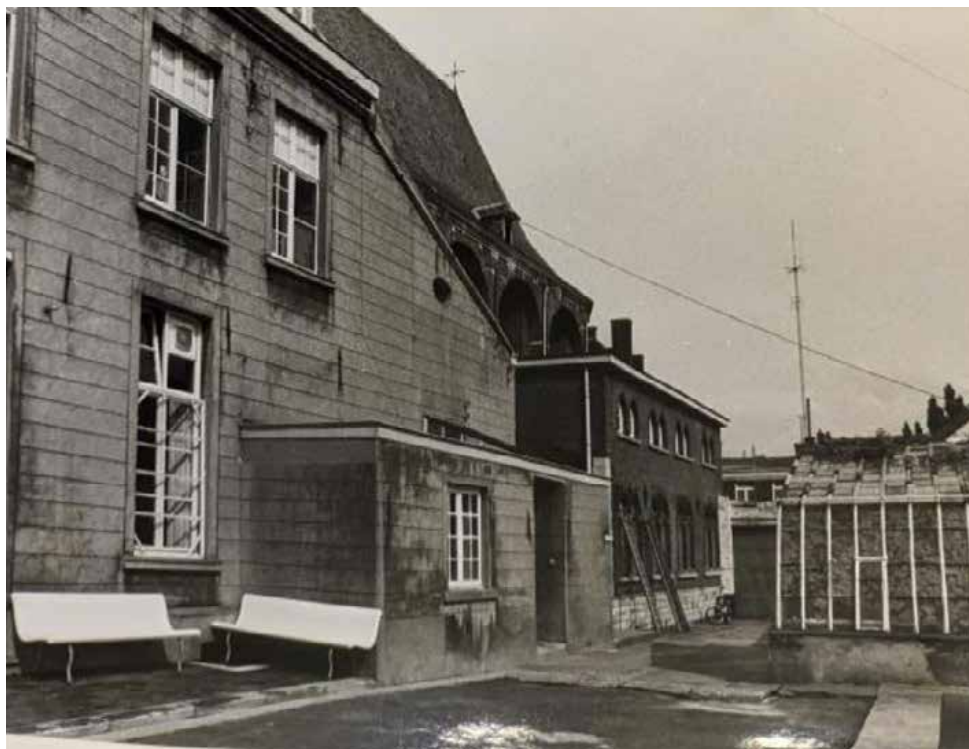
1983 - zicht op zuidvleugel en voormalige serres van de boerderij
