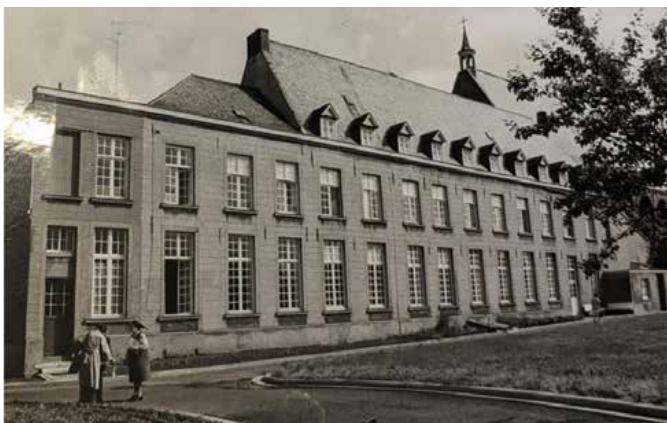
Achtergevel zuidvleugel voor verbouwing 1983
