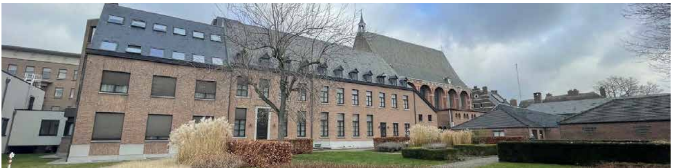
De volledige zuidgevel vandaag, met het metselwerk en de storende westzijde
