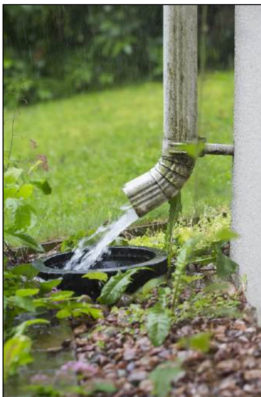
Figuur 129: Afkoppelen dakafvoer van het afvoerstelsel.
