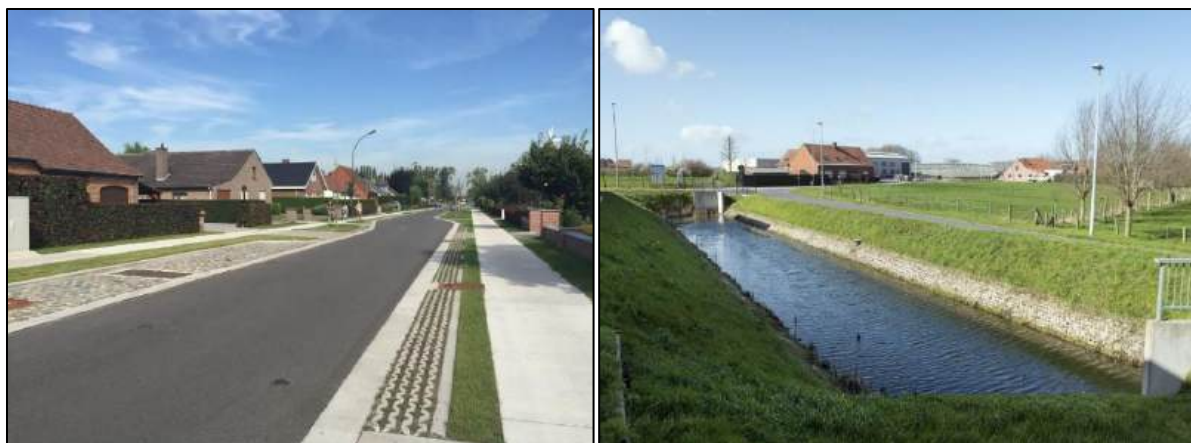
Figuur 131: Links: Lokale infiltratie wegverharding en fietspad. Rechts: Infiltratiebekken.
