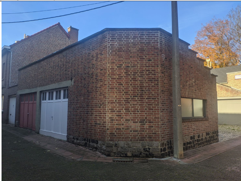
Garages straatkant in 2022: hergebruik van kwartsiet in de plint
