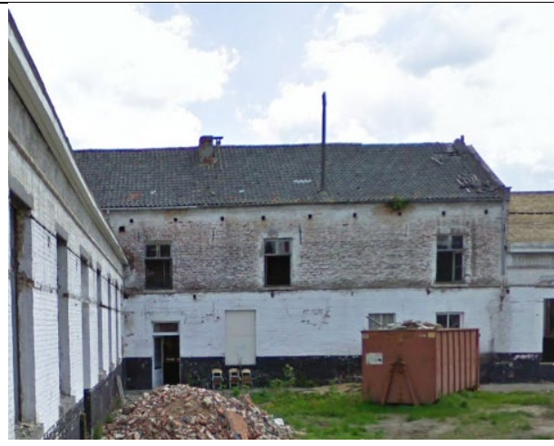
Toestand in 2009: achterzijde hoofdgebouw
