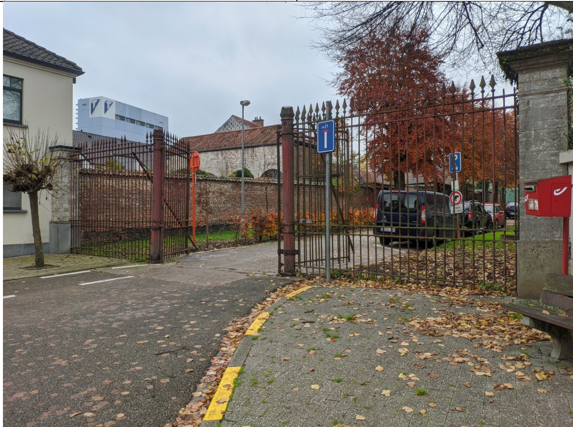
Inkom Novicedreef met ijzeren hekken en poort tussen twee kolommen in gietijzer in zijn geheel gevat tussen twee vierkante pijlers in gobertange met fraaie geprofileerde deksteen
